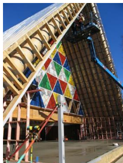
(شكل 16) الهيكل الإنشائي للكنيسة من أنابيب الورق المقوى
