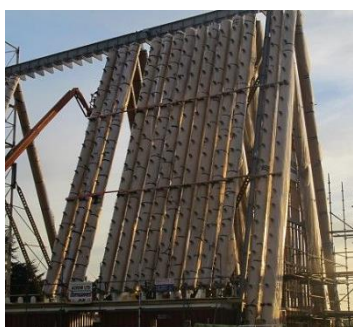
(شكل 16) الهيكل الإنشائي للكنيسة من أنابيب الورق المقوى
